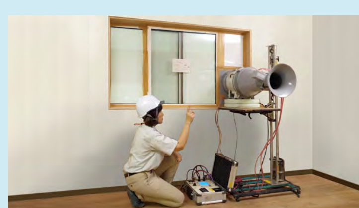
全棟気密測定を実施
